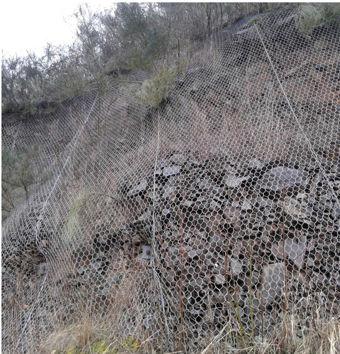
Obr. č. 4.1-4 Skalní výchoz souběžný s lodním výtahem a velké množství opadaného materiálu zachyceného do bezpečnostních sítí
